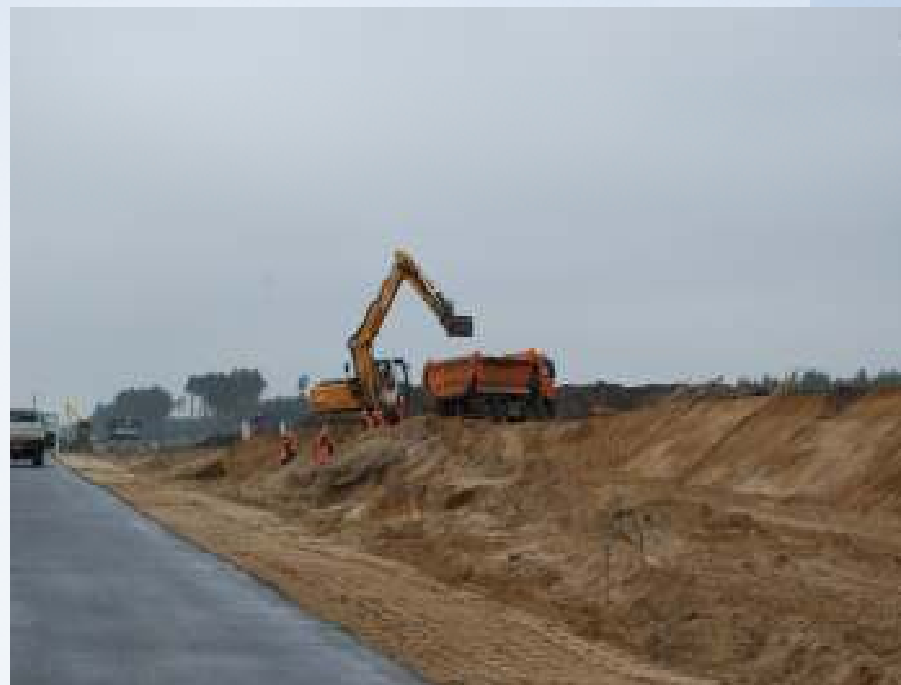
Wykonanie wykopu km 7+150
