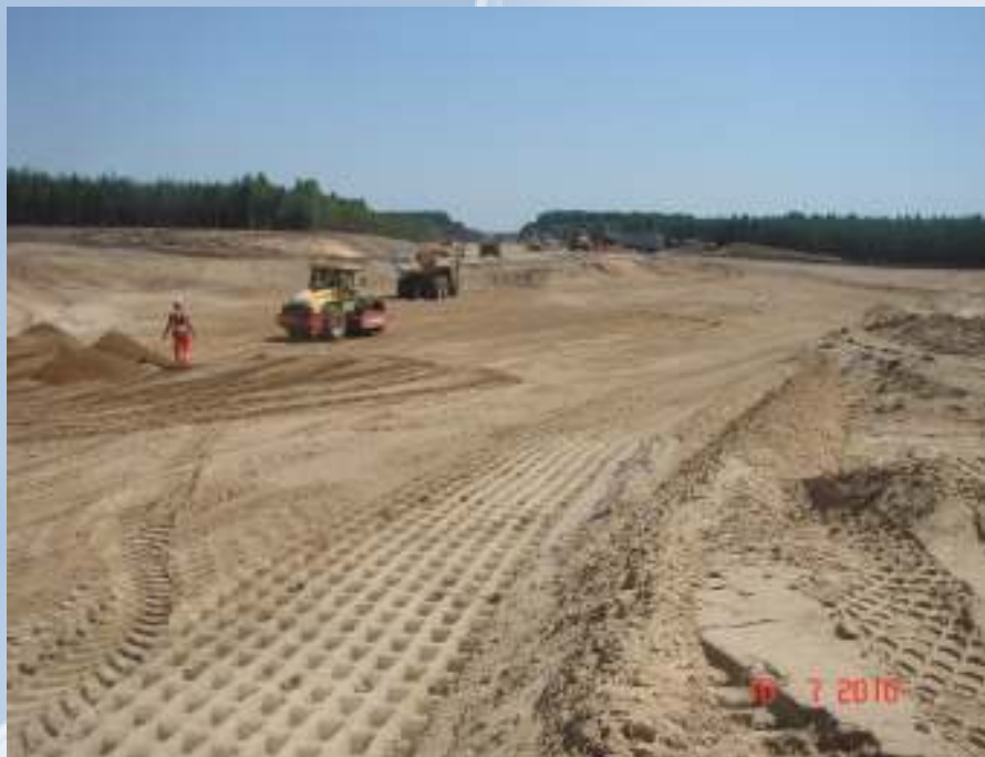
Budowa nasypu km 10+600
