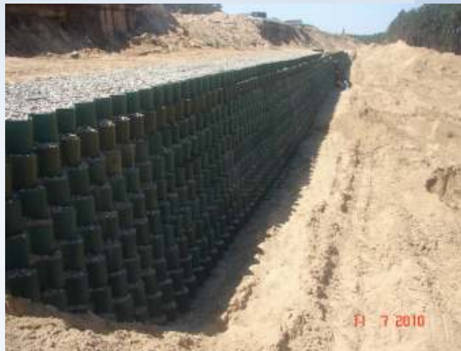
Wzmocnienie skarp nasypów i wykopów km 4+800
