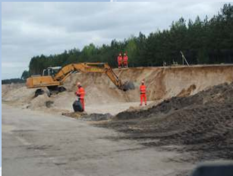
Wykonanie wykopu km 11+870
