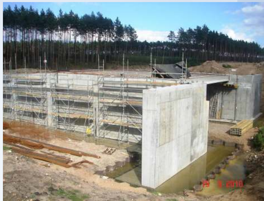
Budowa obiektu PA - 11 km 20+431
