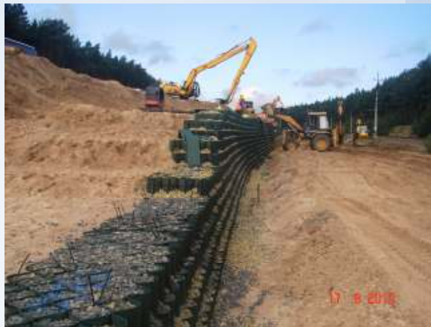
Wzmocnienie skarp nasypu w pobliżu torowiska
