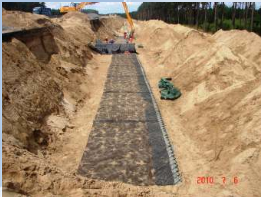
Wzmocnienie skarp nasypów i wykopów km 4+200
