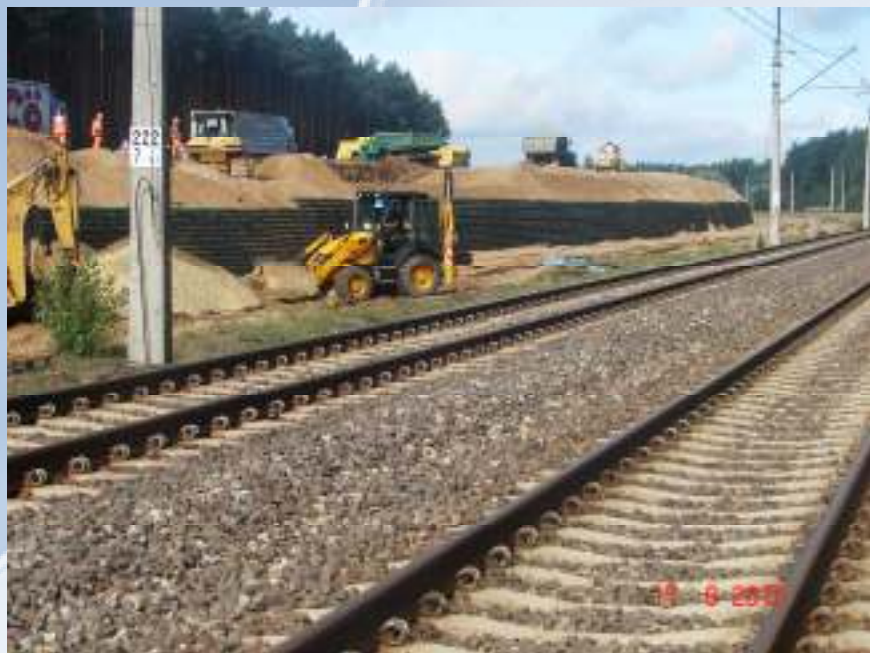
Wzmocnienie skarp nasypu w pobliżu torowiska
