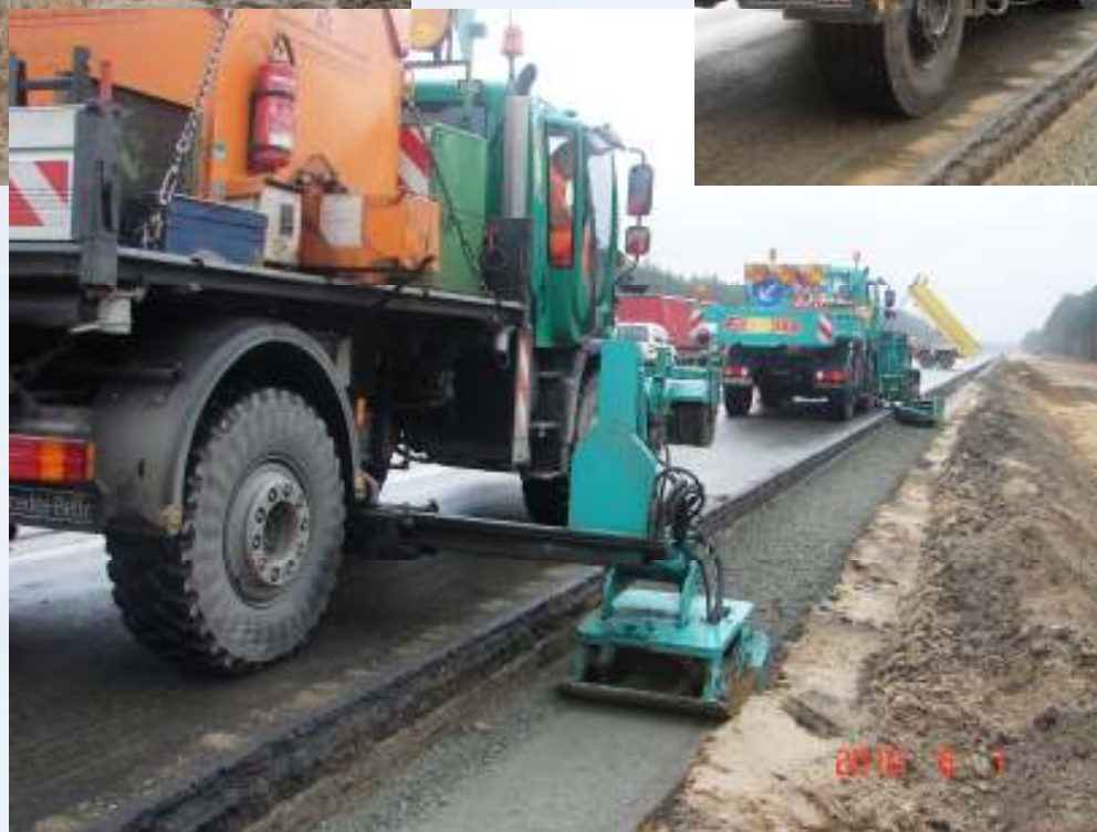
Poszerzenie istniejącej nawierzchni DK 2
