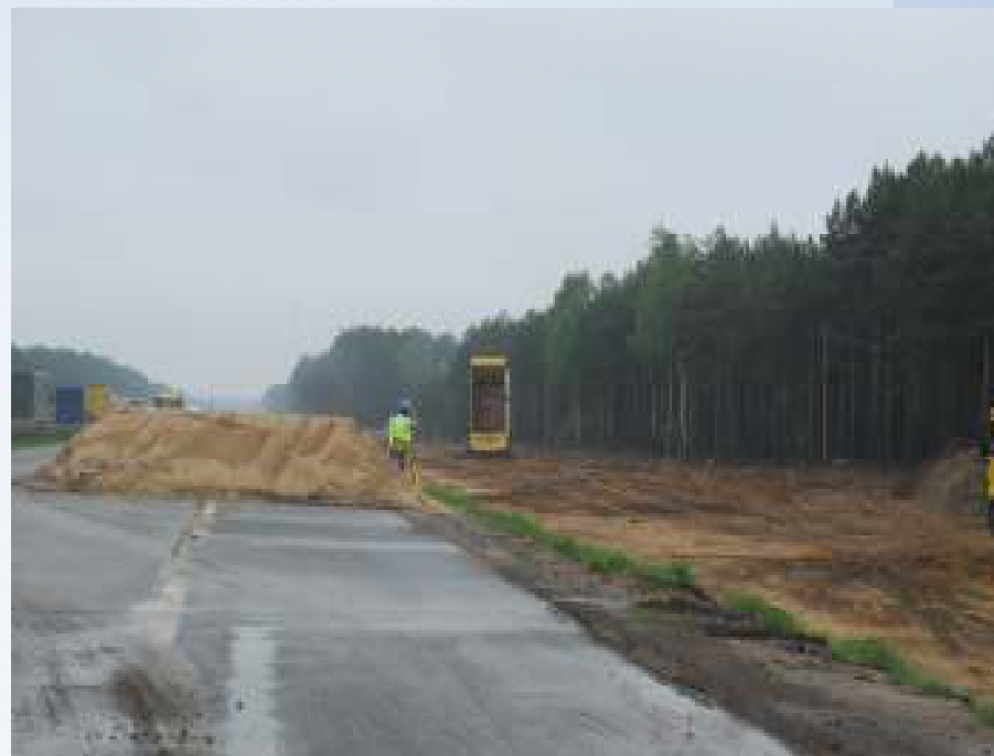
Budowa nasypu km 8+600
