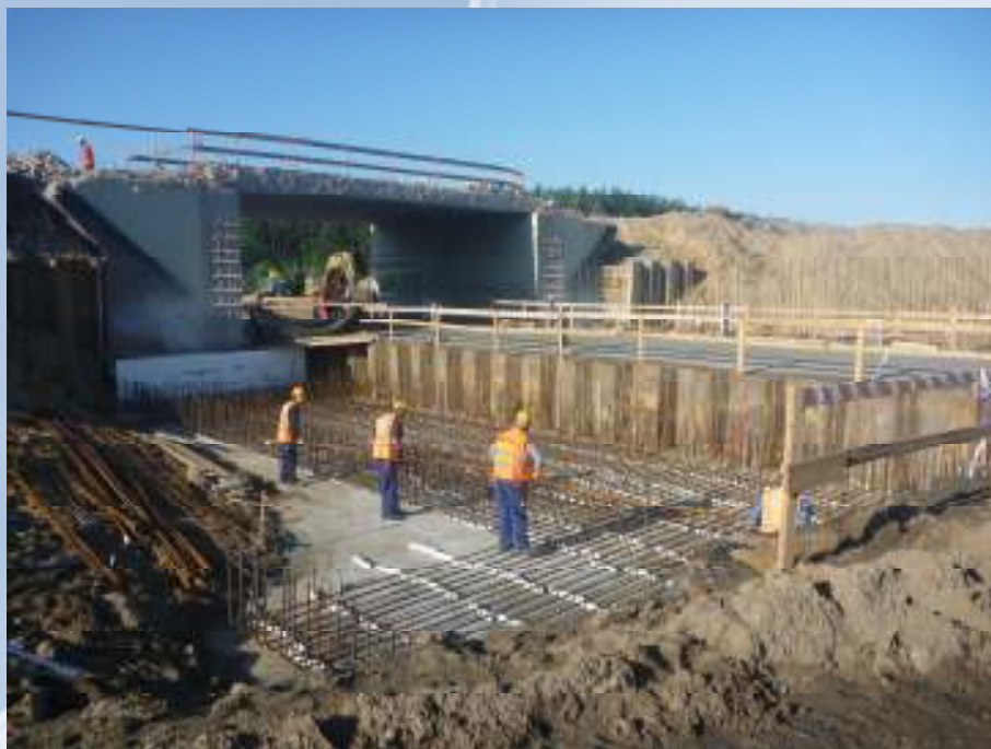
Budowa obiektu WA - 10 km 18+818
