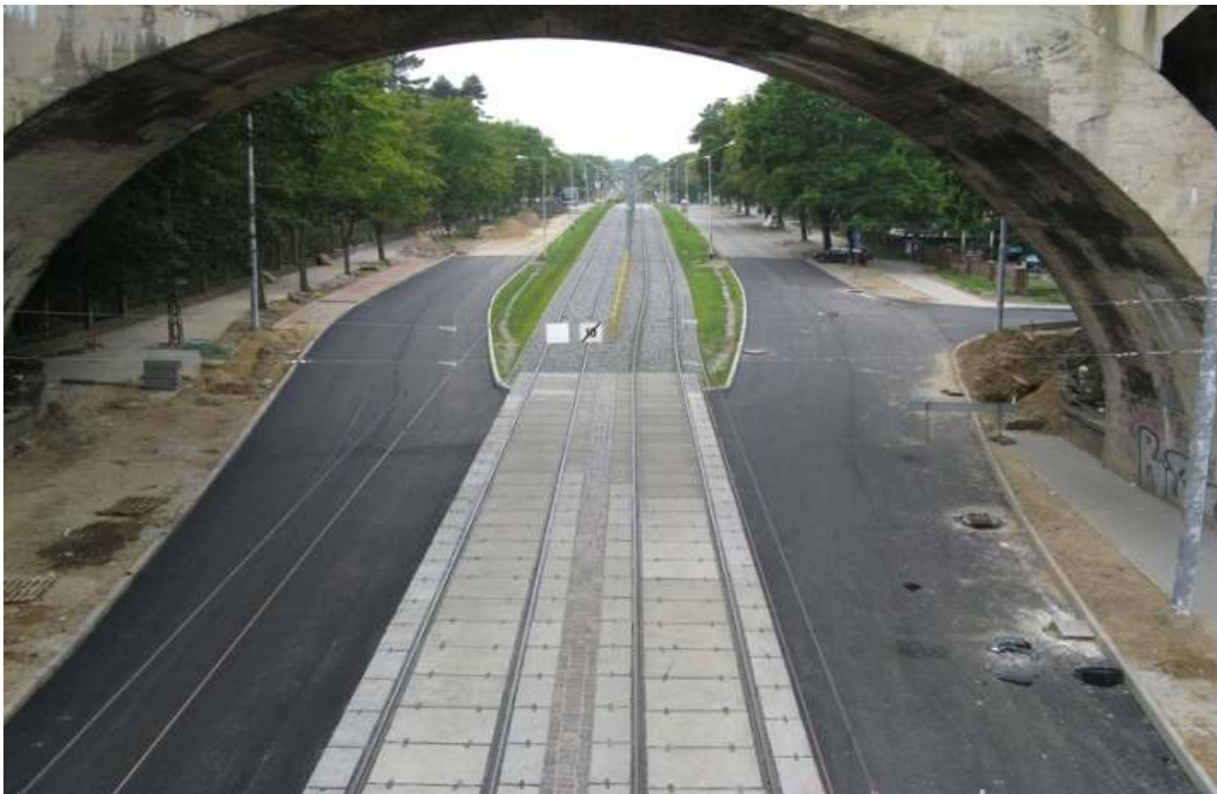
Zmodernizowane torowisko tramwajowe wraz z siecią trakcyjną ul. Ku Słońcu na odcinku od ul. Tennisowej do Głównej Bramy Cmentarza Centralnego
