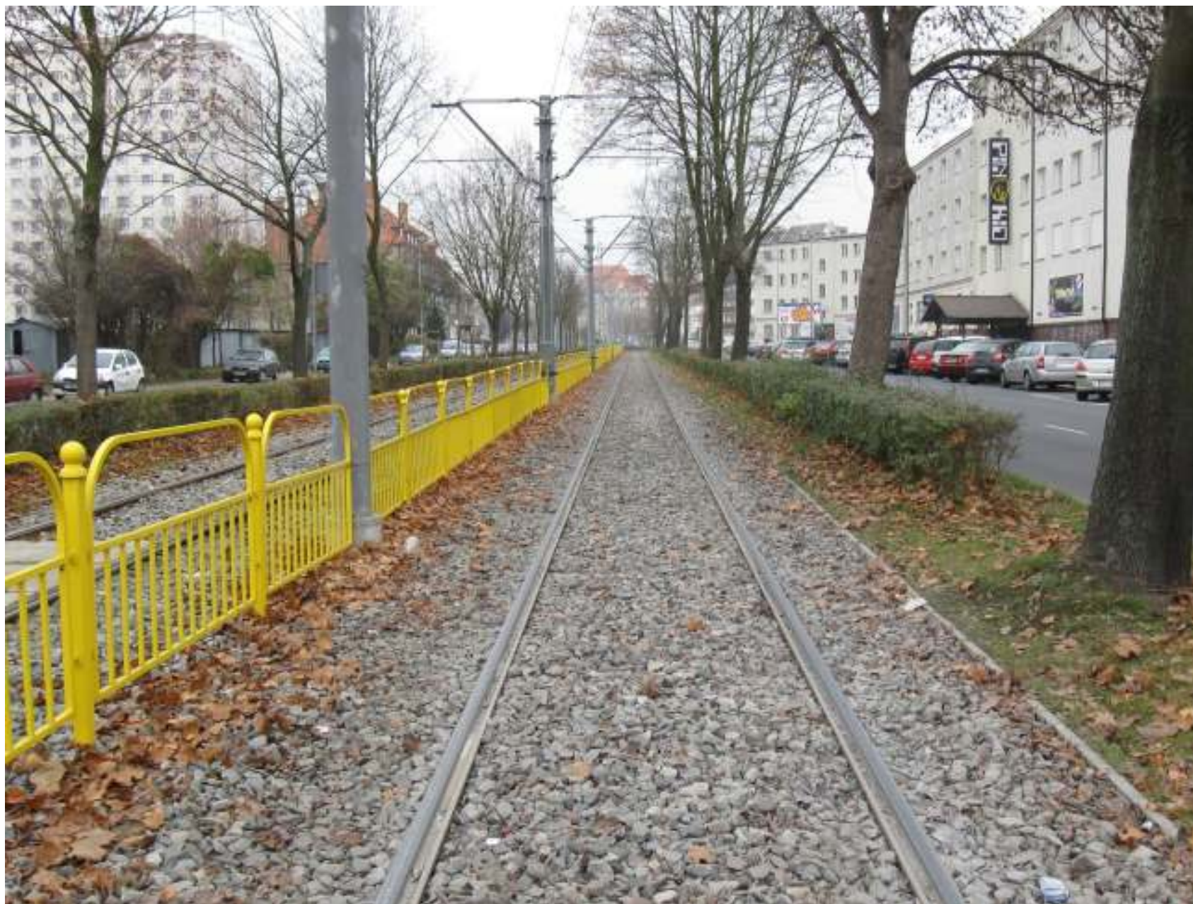
Zmodernizowane torowisko tramwajowe wraz z siecią trakcyjną ul. Sikorskiego od Ronda Rotmistrza W. Pileckiego do Ronda Ojca Siwka
