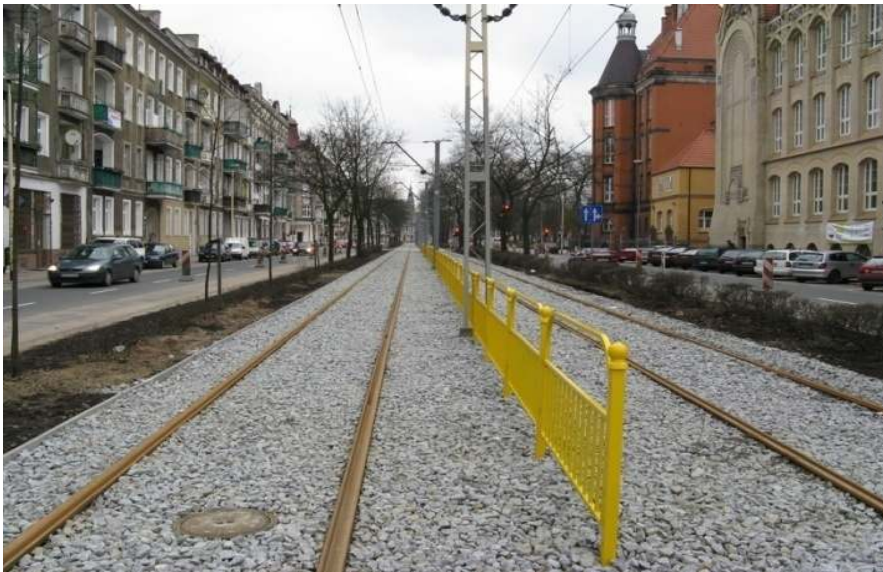
Zmodernizowane torowisko tramwajowe wraz z siecią trakcyjną ul. Gen. W. Sikorskiego od pl. T. Kościuszki do Ronda Ojca Siwka
