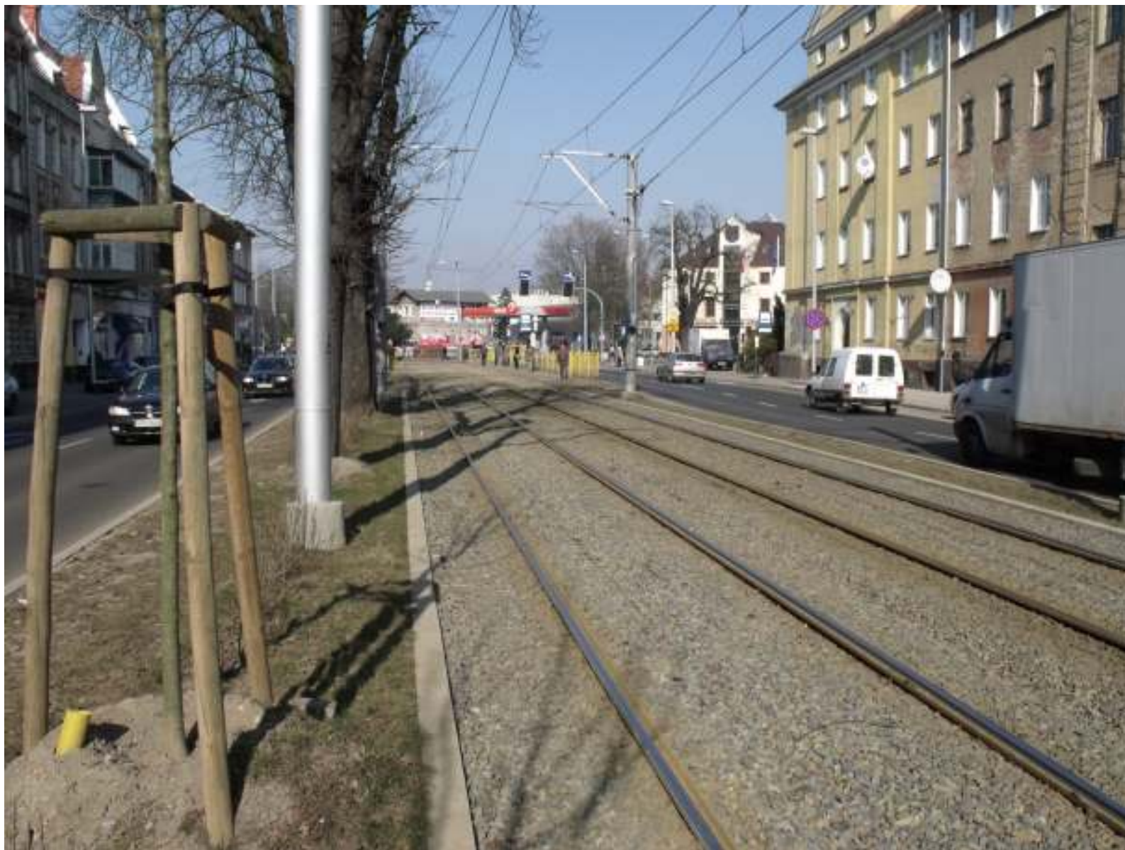
Zmodernizowane torowisko tramwajowe wraz z siecią trakcyjną ul. Boh. Warszawy od przystanku przy ul. Mickiewicza do ul. Jegiellońskiej
