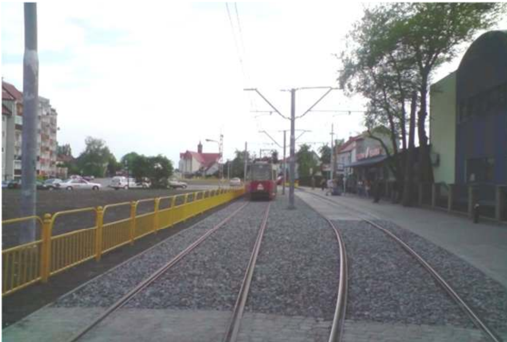
Zmodernizowane torowisko tramwajowe wraz z siecią trakcyjną Pętla Gumieńce ul. Kwiatowa
