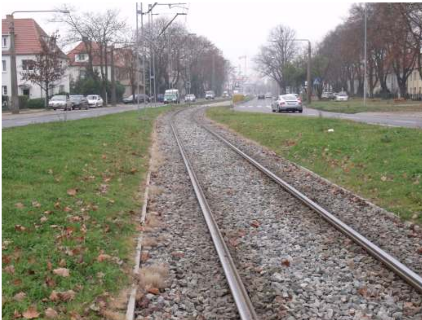
Modernizacja torowiska tramwajowego wraz z siecią trakcyjną ul. Ku Słońcu od ul. Krętej do ul. Kwiatowej
