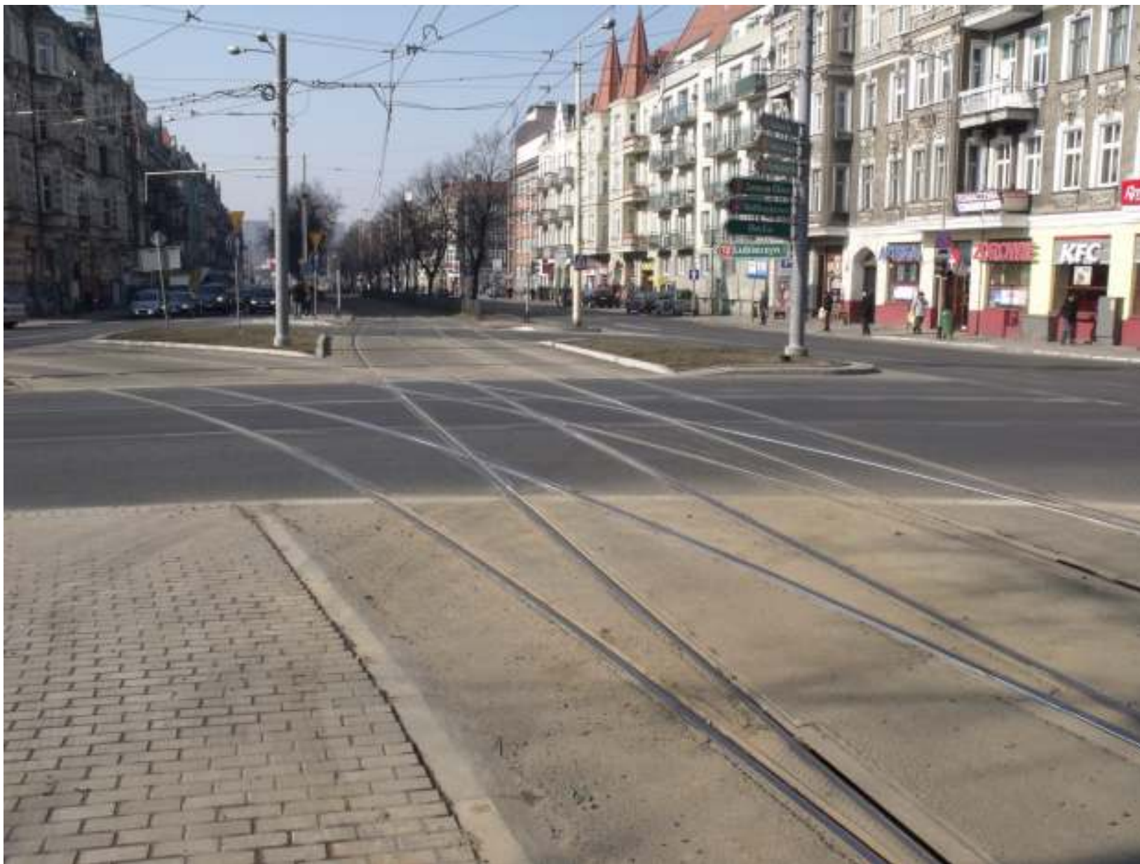
Modernizacja torowiska tramwajowego wraz z siecią trakcyjną w węźle komunikacyjnym Plac Kościuszki
