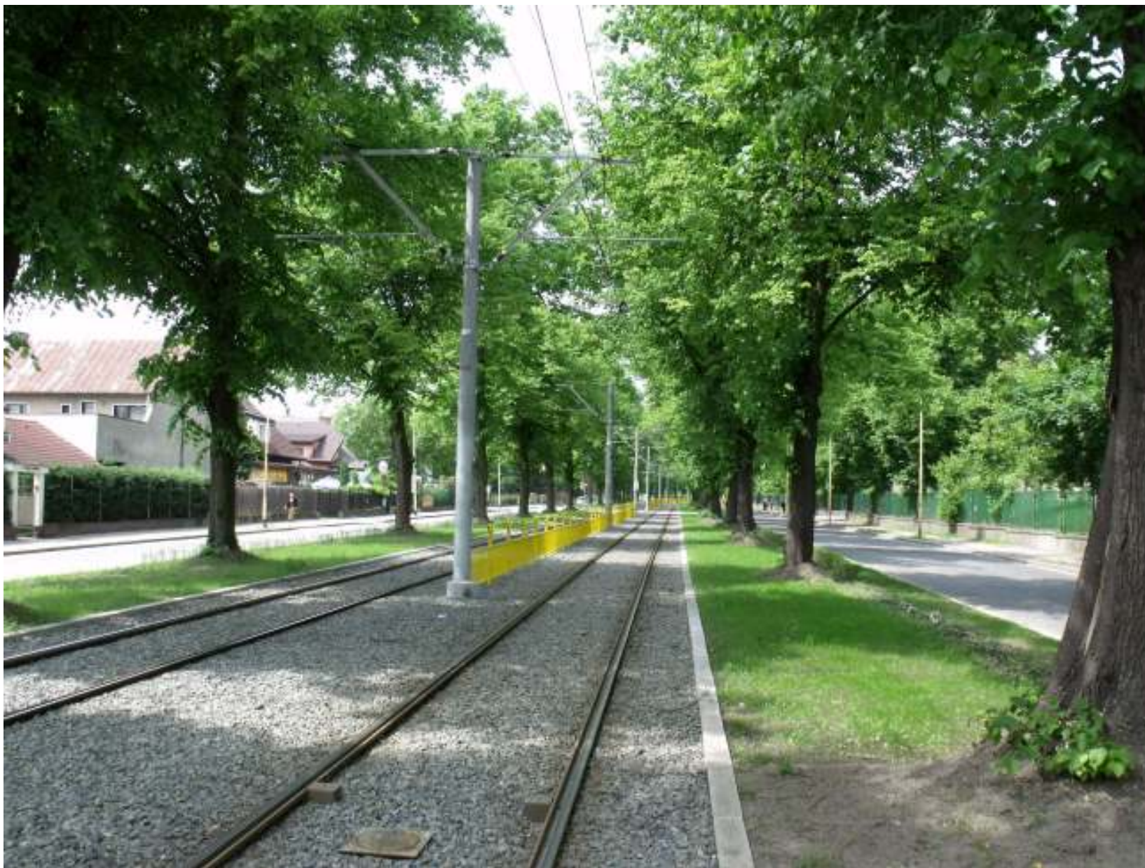
Zmodernizowane torowisko tramwajowe wraz z siecią trakcyjną ul. Żołnierska od ul. Somosierry do Pętli Krzekowo
