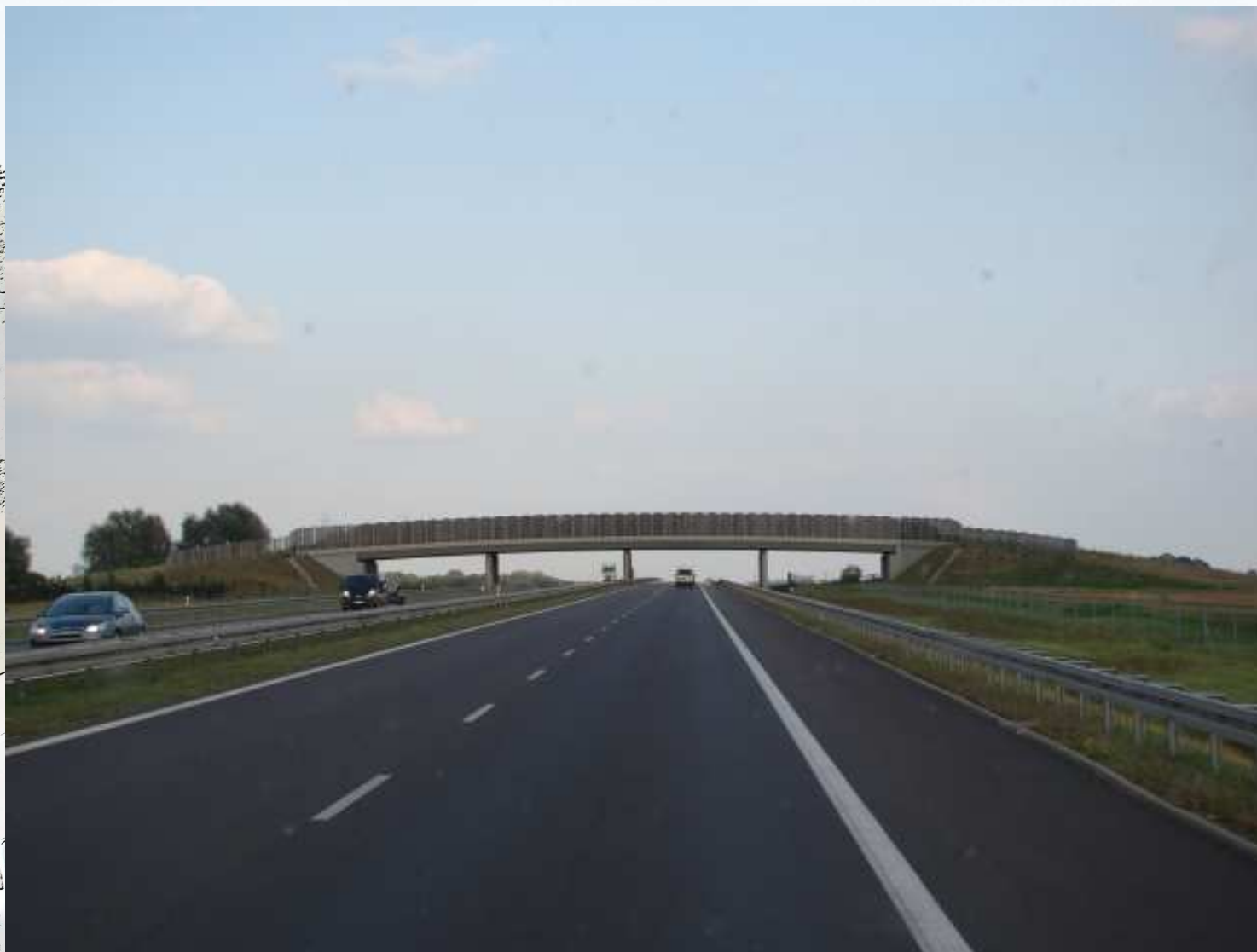
Przejście górne nad autostradą A2 (fot. A. Sołowczuk)
