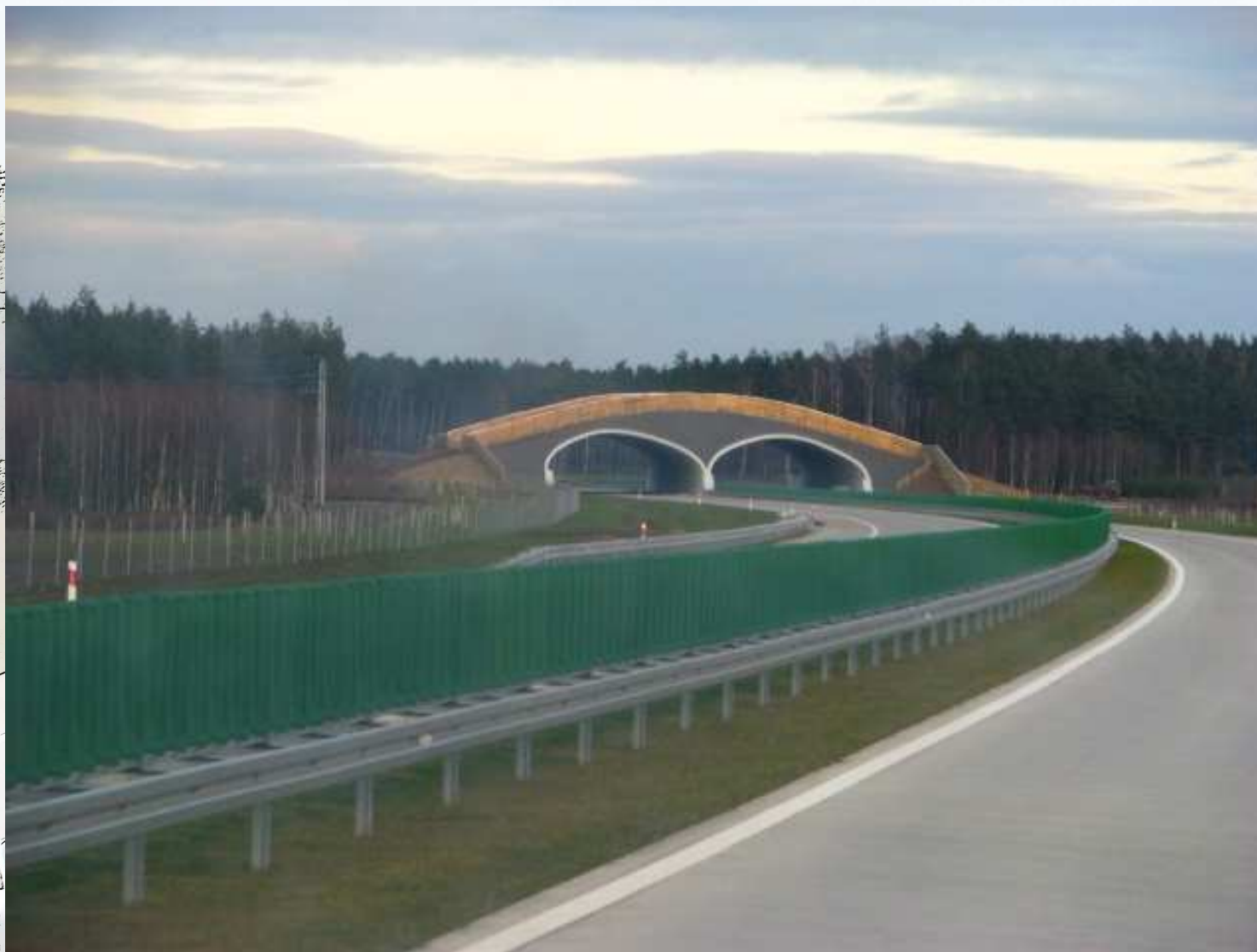
Przejście górne nad autostradą A4 (fot. A. Sołowczuk)
