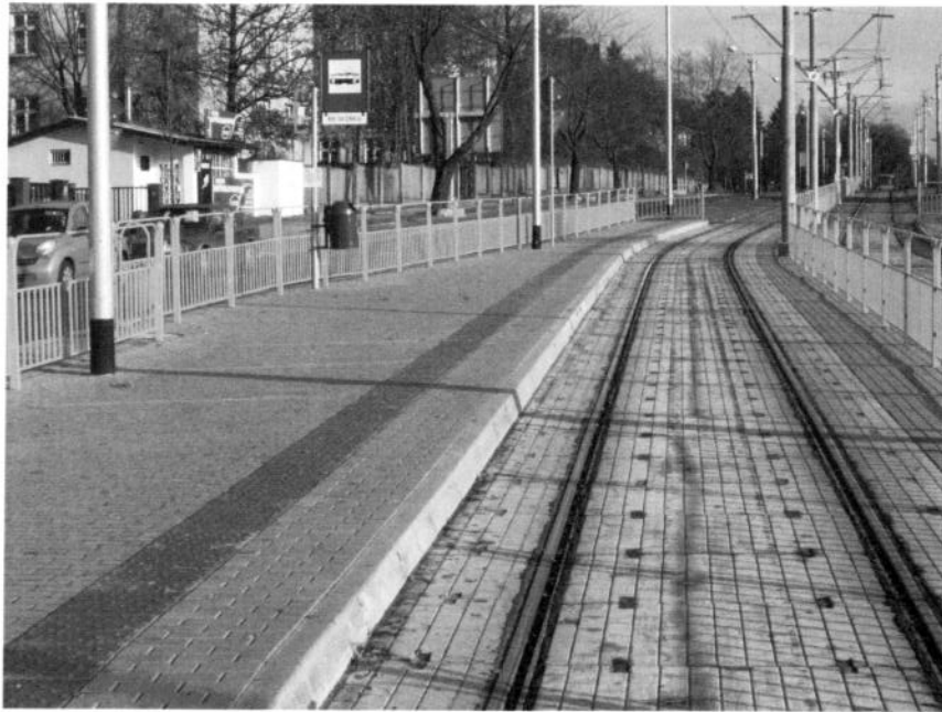
Rys. 2 Standardowe rozwiązanie peronu przy torowisku wydzielonym - Szczecin
