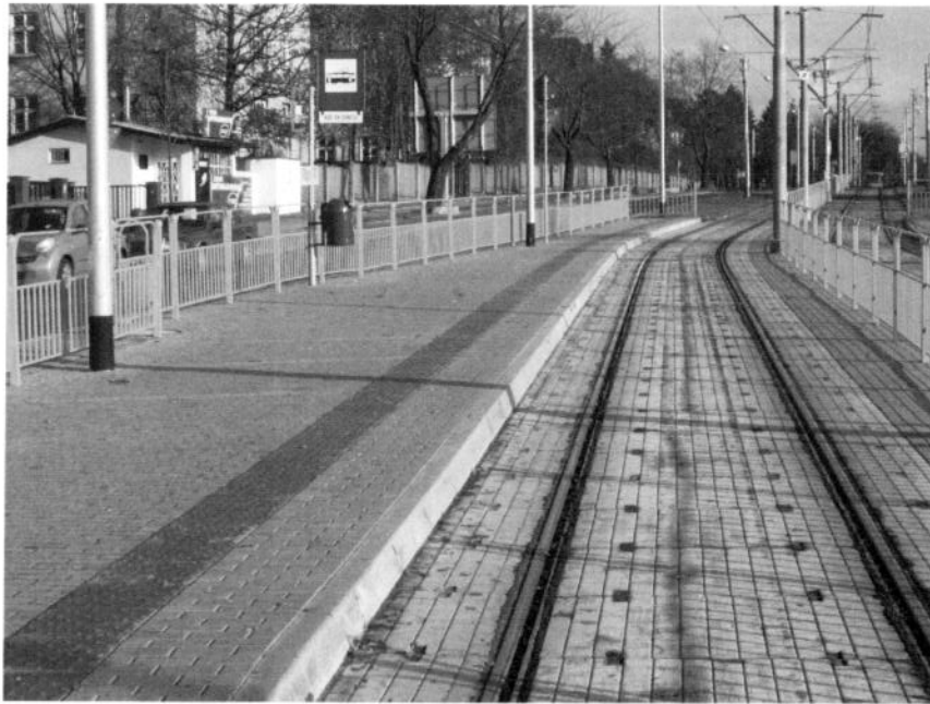
Rys. 2 Standardowe rozwiązanie peronu przy torowisku wydzielonym - Szczecin
