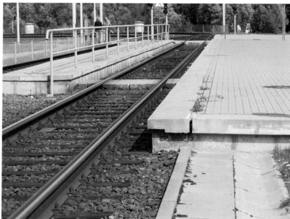
Rys. 5 Konstrukcja peronów na przystanku końcowym PST
